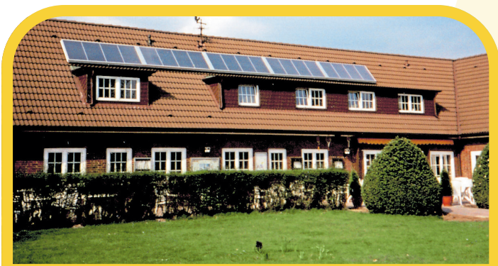
1999: Die Firma VEH plant und liefert die thermische Solaranlage des Eimsbütteler Turnvereins (ETV), Gewinner des Hamburger Solarpreises
